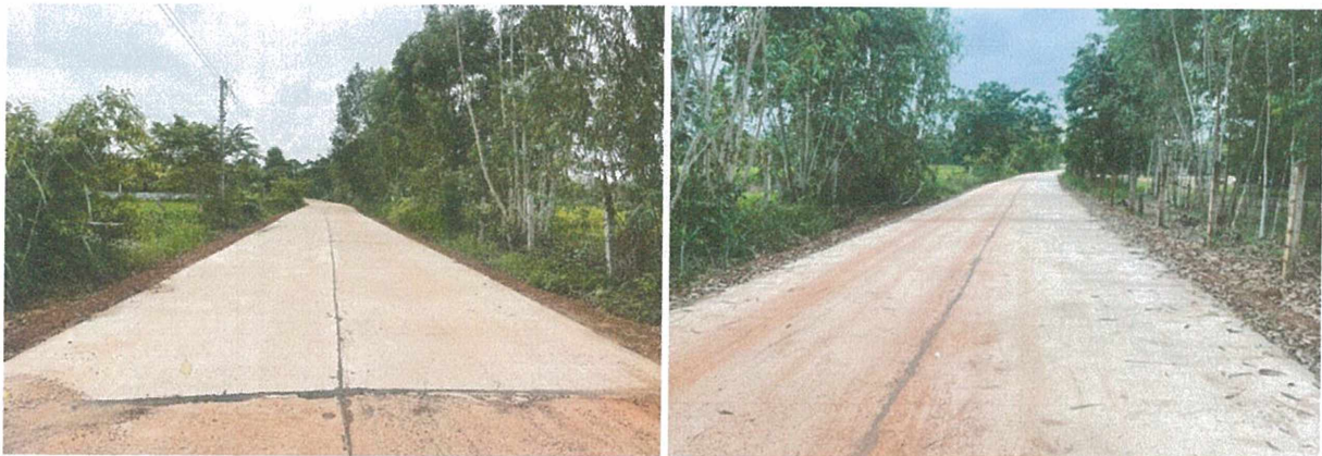
ดำเนินการแล้วเสร็จ
