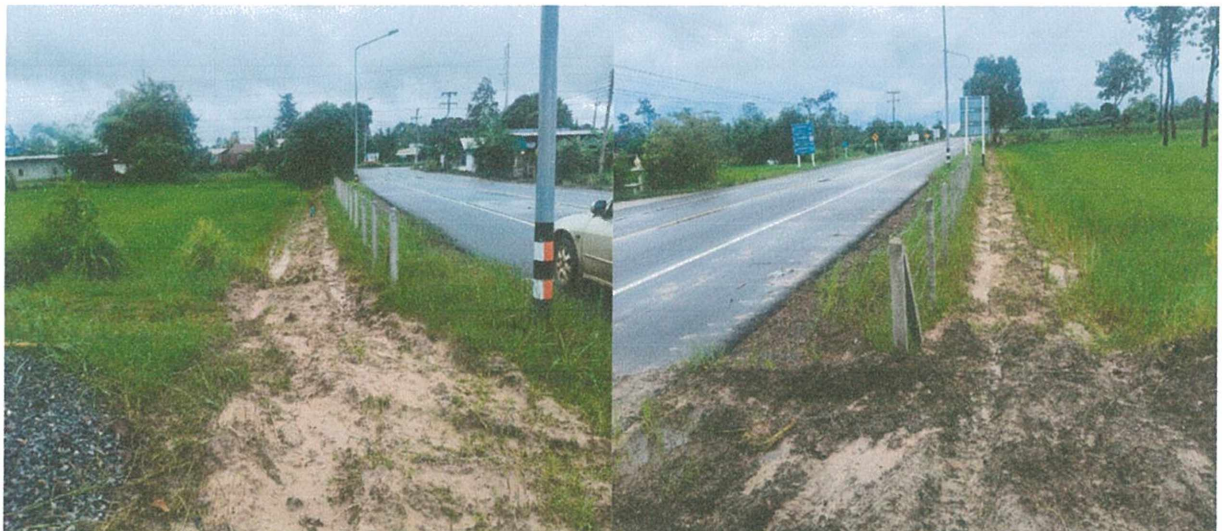
ดำเนินการแล้วเสร็จ
